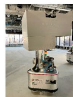
Tバー〔3号機〕 運搬・金物取付
