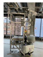
天井ボード 運搬・取付
