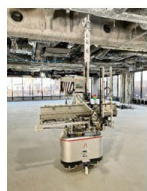
吊りボルト 運搬・取付
