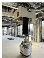
Tバー〔2号機〕 運搬・金物取付
